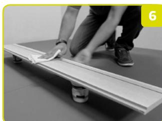
**5 e 6.** Cortar o perfil em 45° conforme a imagem 5. Limpe o verso do perfil removendo todos os resíduos e rebarbas de cortes.
