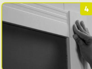
3 e 4. Coloque a peça bem encostada na parede e alinhe-a ao piso. Pressione bem contra a parede para perfeita aderência das suas superfícies.
