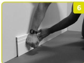
6. Agora coloque a barra na posição de instalação e pressione contra a parede. Para um resultado mais eficiente, firme com o auxílio da mão ou de uma marreta de borracha.
